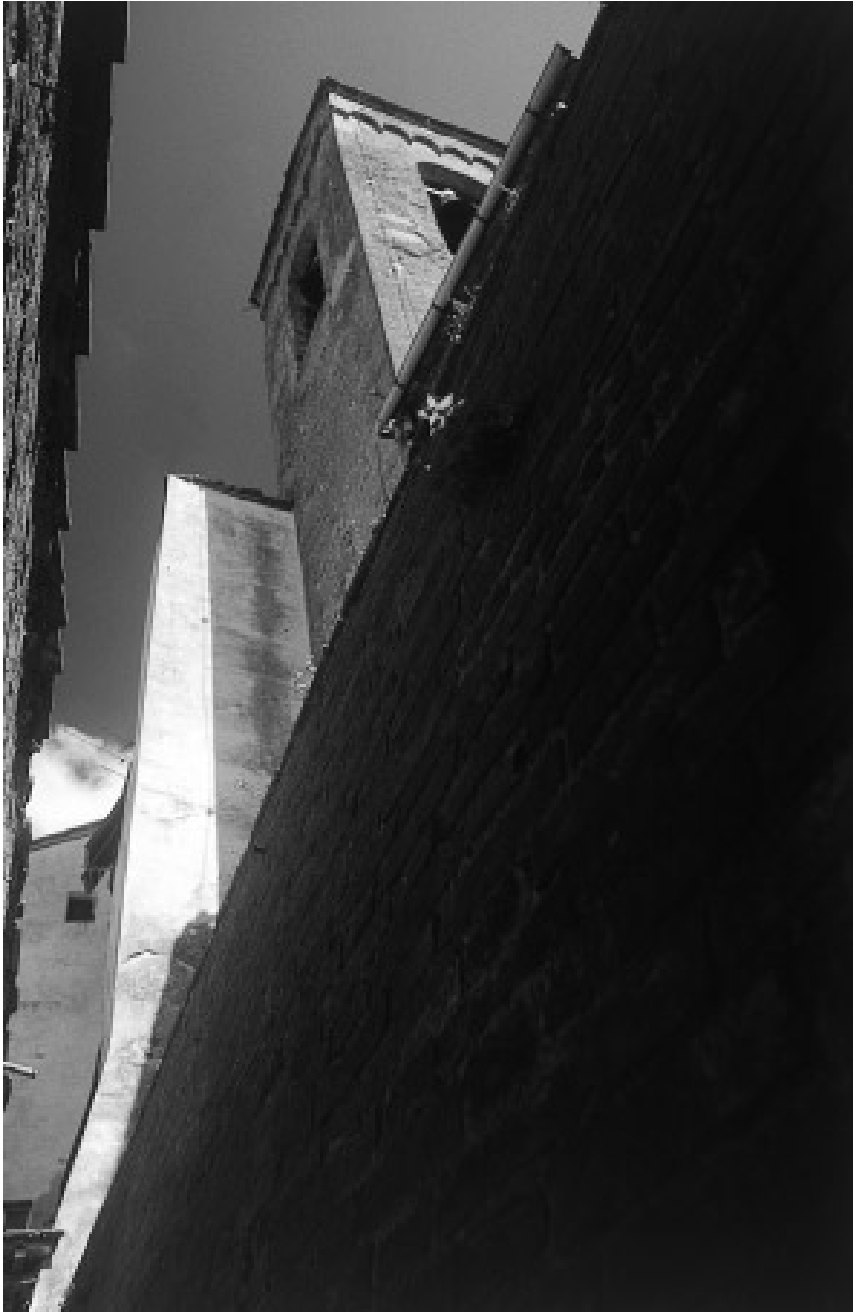
Fig. 3. Muratura in cotto probabilmente residuo della prima cinta muraria.
